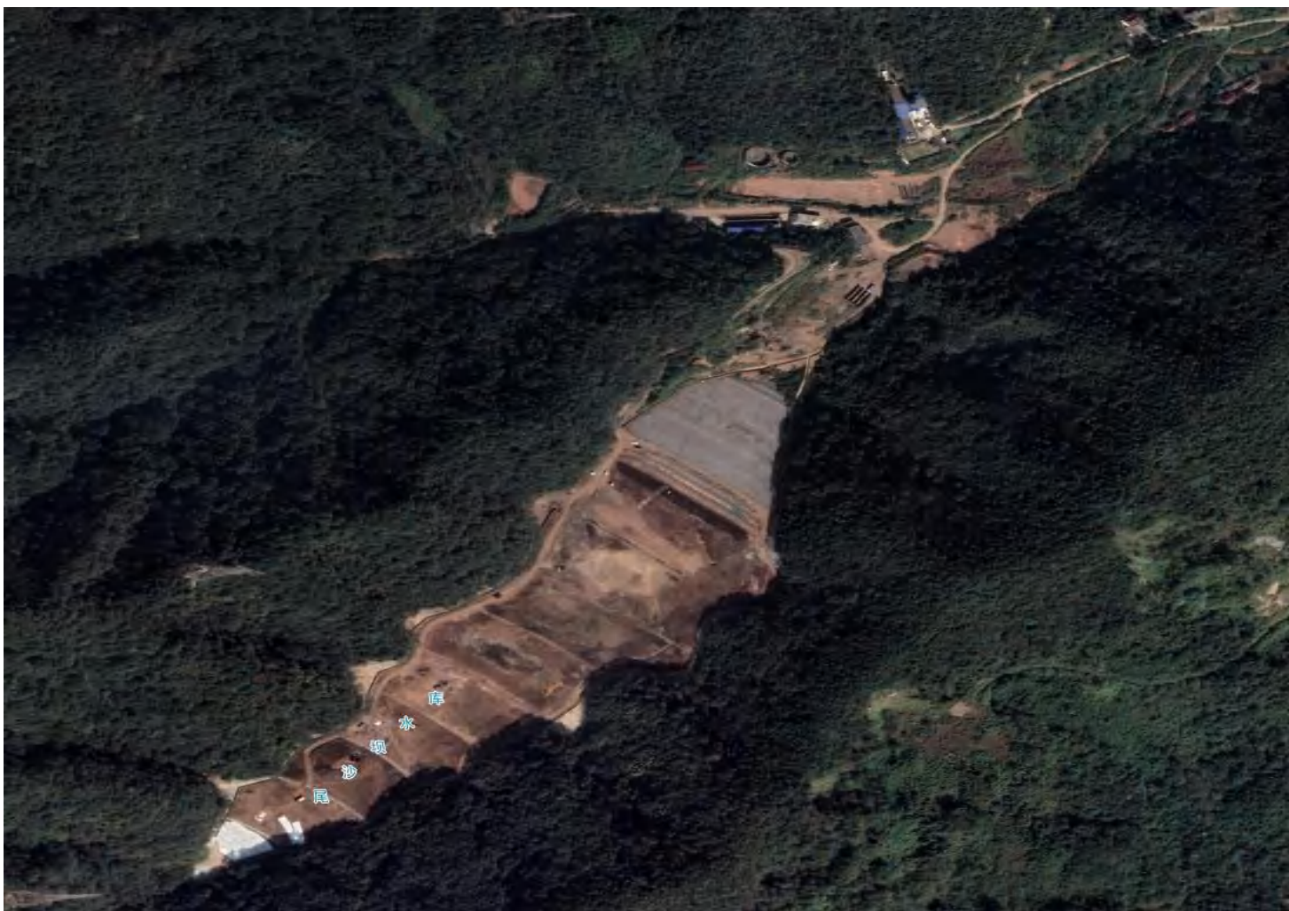
施工期卫星遥感影像图
